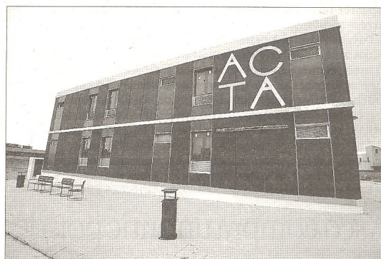
Imatge del flamant nou edifici de l'Arxiu Comarcal de la Terra Alta, ubicat al municipi de Gandesa. FOTO: JOAN REVILLAS
