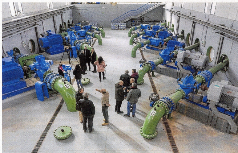
Es construirà a l'estació de bombament de la Zona Oriental de la Terra Alta (REGZOTA). FOTO: J. REVILLAS
