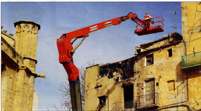
Imatge de les obres d'enderroc a la plaça de l'Absis. FOTO JJ CAROT
