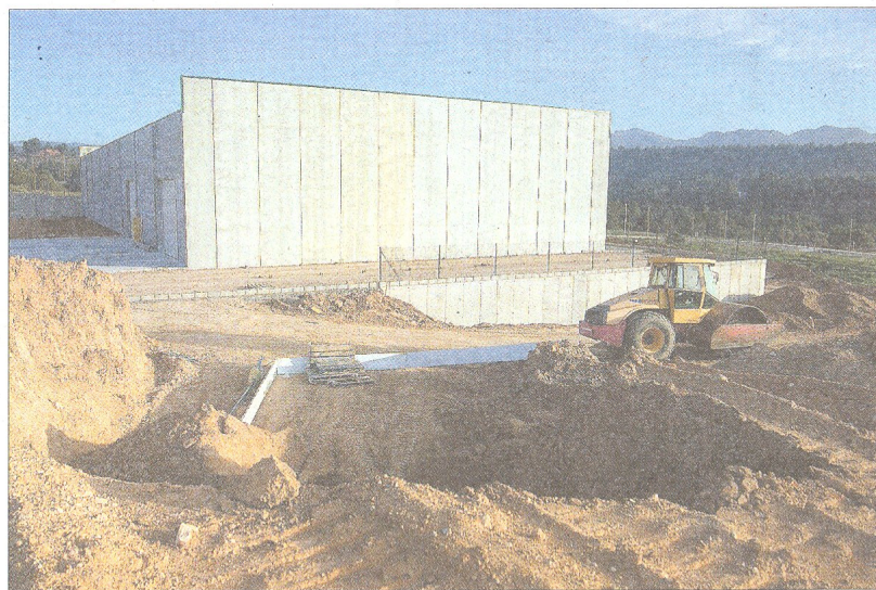
La nau que acollirà la futura planta de triatge és el primer edifici que s'aixeca al polígon del Molló. FOTO: J. REVILLAS
