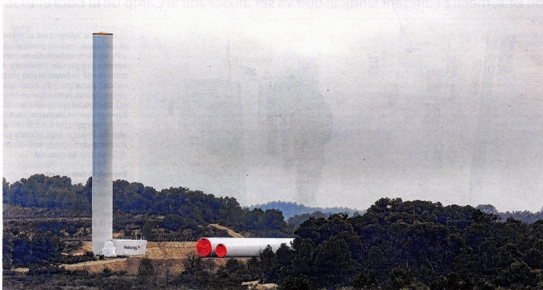
La central èòlica Tres Termes que actualment s'està construint entre Batea, Vilalba dels Arcs i la Pobla de Massaluça. FOTO: JOAN REVILLAS
