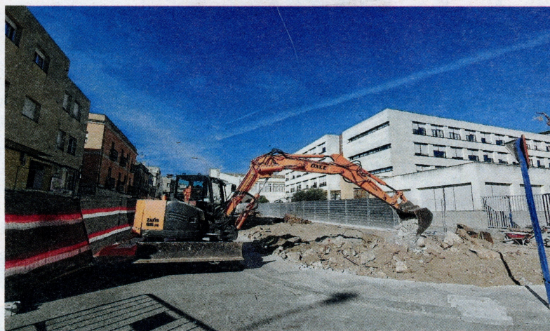
Obres en execució del consultori local de Jesús. FOTO: JOAN REVILLAS
