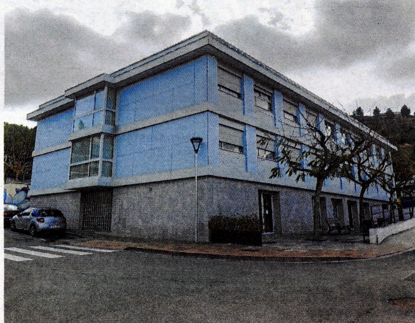
Es preveuen obres de millora a la Residència d'Avis. FOTO: JOAN REVILLAS
