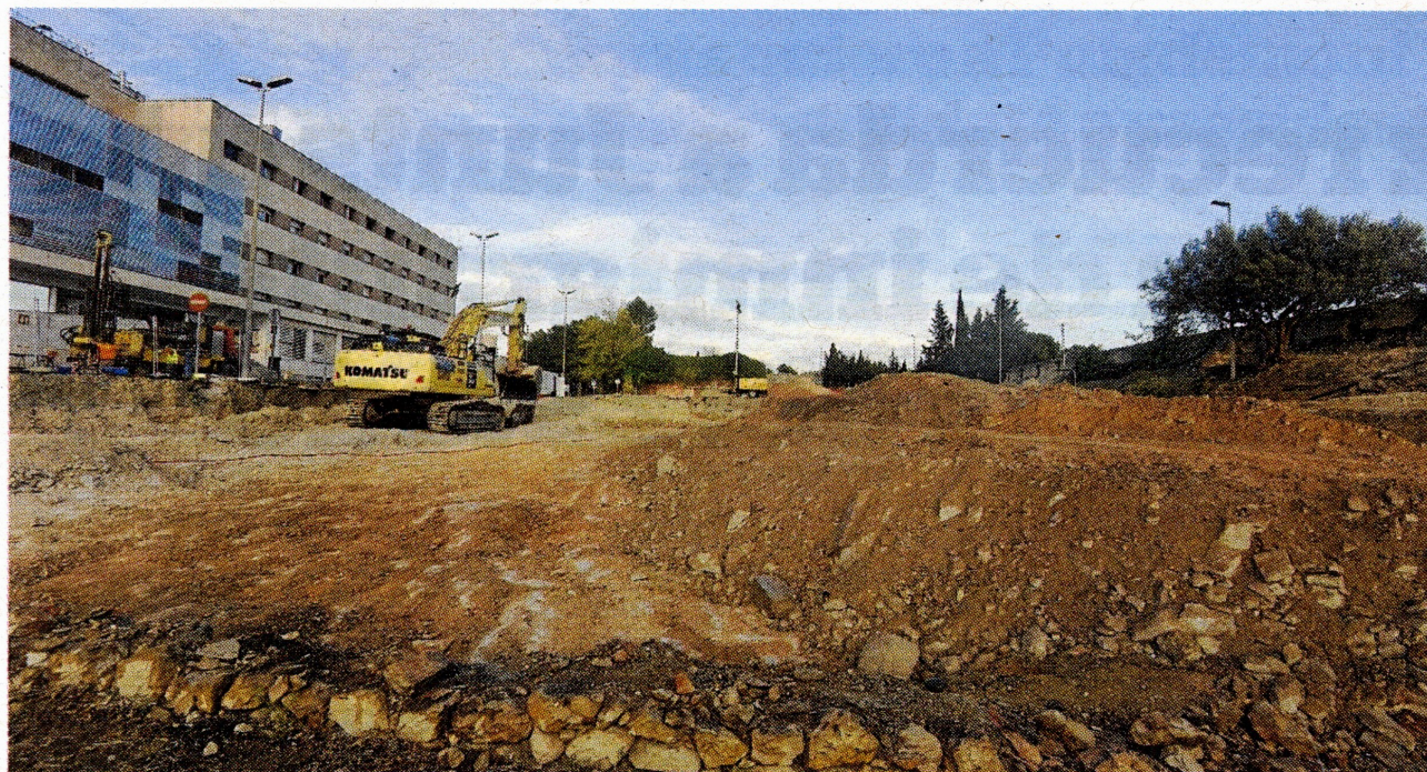
Durant les obres d'ampliació del centre van aparèixer restes del segle XVII o XVIII. FOTO: JOAN REVILLAS
