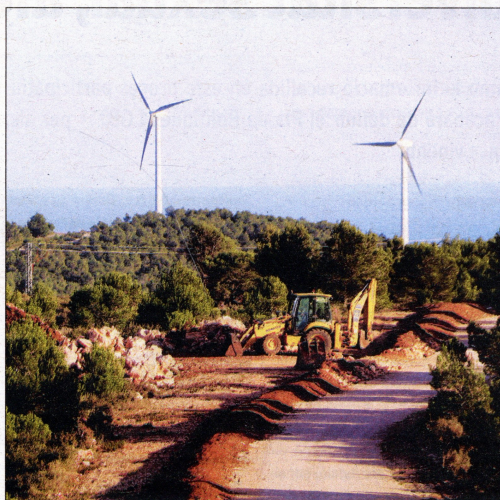
Màquines treballant prop dels molins del parc Colladetes.
