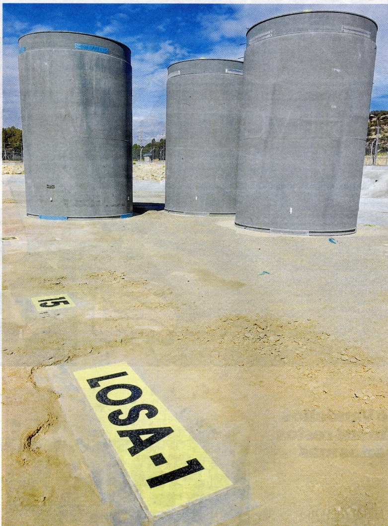
Las centrales de Ascó tienen desde 2013 un Almacén Temporal Individualizado que se ampliará. FOTO: J. REVILLAS
