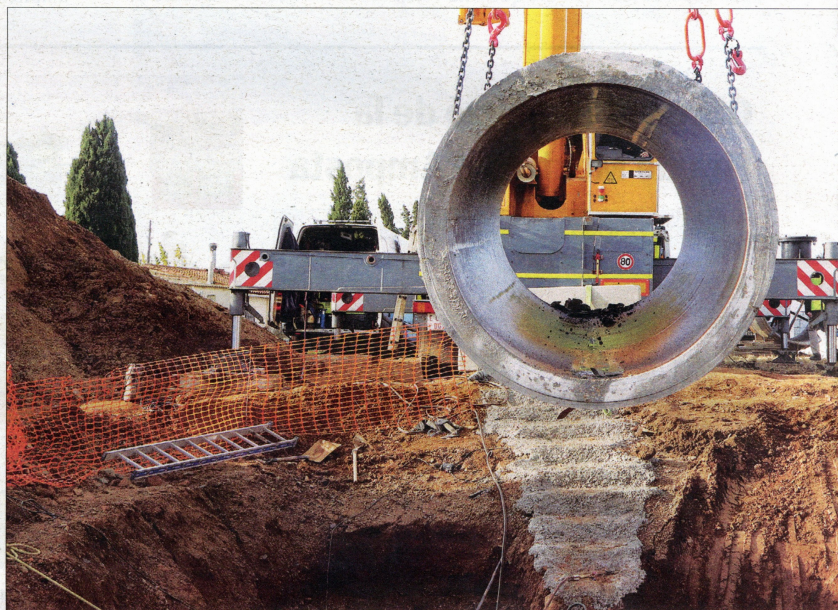
Obres recents per canviar un tram de la canonada principal del CAT, la xarxa del qual podria abastir vaixells amb aigua amb destí
