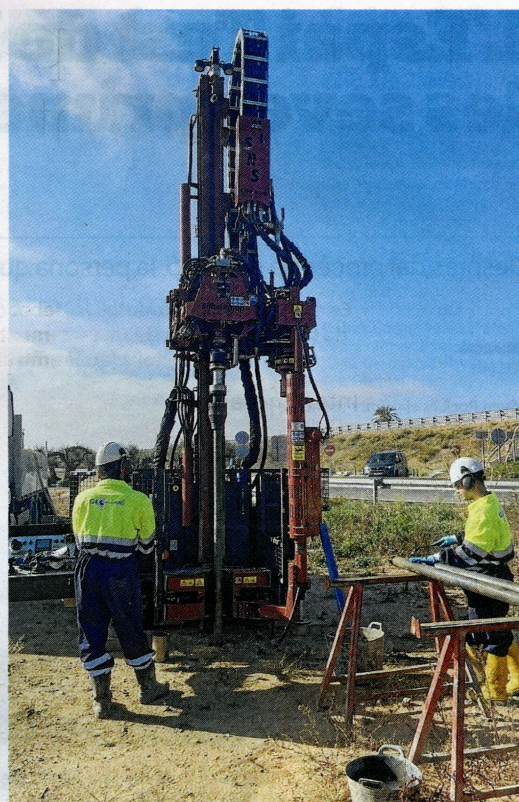
Operaris de l'empresa contractada extraent terra submarina amb una maquinària especial prop del litoral d'Alcanar. FOTO: GRAP
