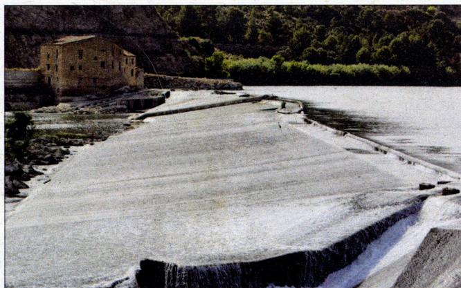
L'Assut de Xerta té una triple funció: origen dels canals de regadiu, resclosa per a la navegació i base d'una minicentral hidroelèctrica.
