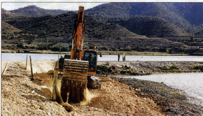
Inici de les obres a l'alçada del camp de regates de Mequinensa. / ACN
