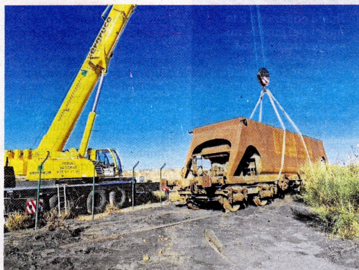
El trasllat del vagó es va efectuar amb una gran grua. FOTO: ENDESA
