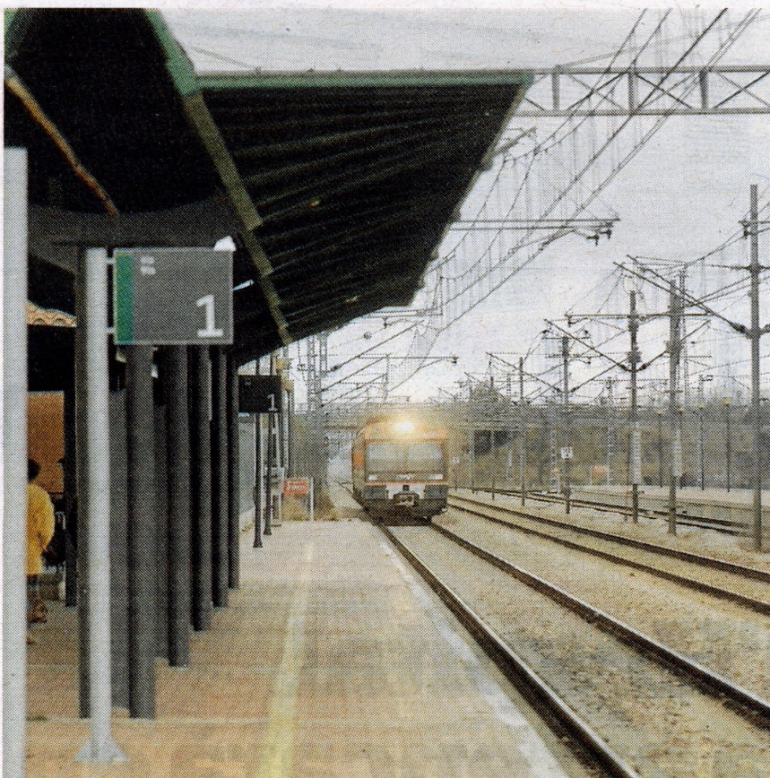
L'estació de tren d'Ulldecona. FOTO: JOAN REVILLAS
