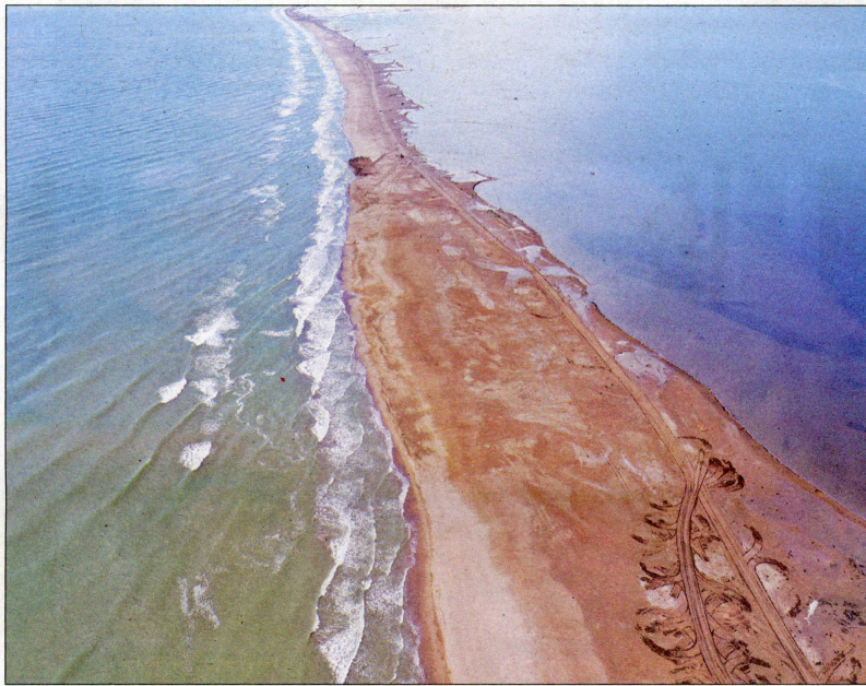
Represa de les obres de reforç del front marítim al Trabucador, que s'allargaran fins a mitjan octubre. / SERVEI PROVINCIAL DE COSTES DE L'ESTAT
