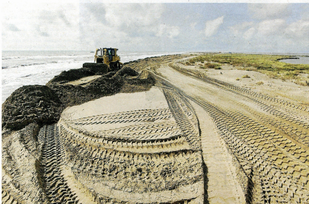
Treballs de moviment d'arenas per reforçar el Trabucador, en aquest cas per part de Costes de l'Estat. FOTO: JOAN REVILLAS
