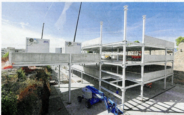
L'aparcament és desmuntable mentre no es construeix el definitiu. FOTO: JOAN REVILLAS
