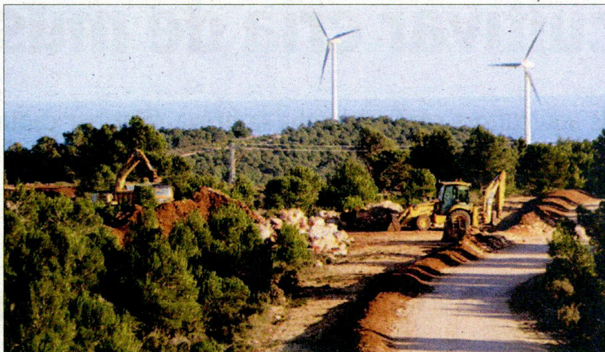
Excavadora treballant a prop dels molins del parc la Collada. / ACN
