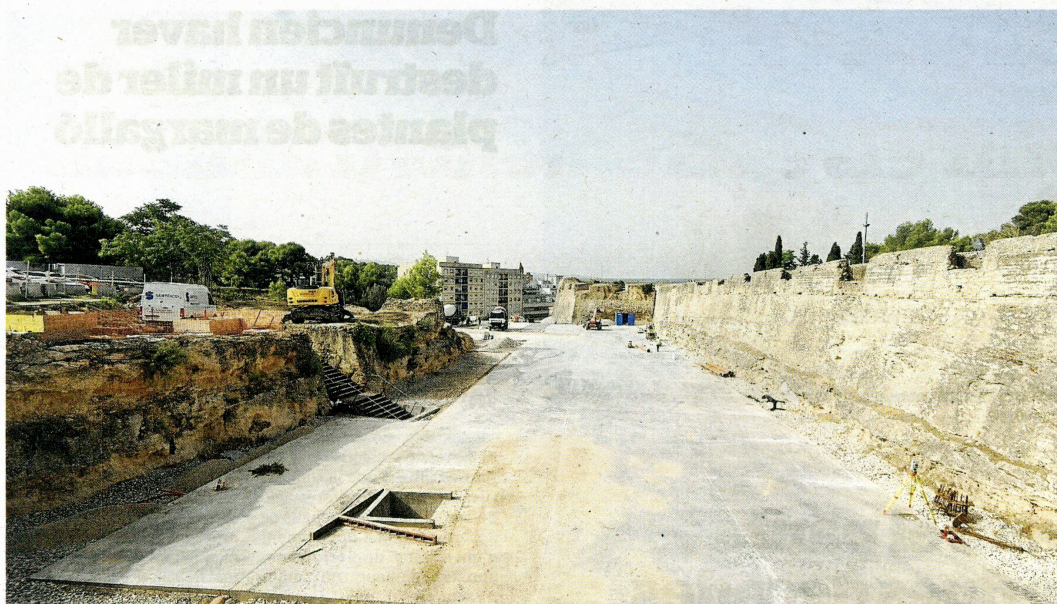
Els fonaments de formigó al fossar estan finalitzant i ara s'instal·larà l'estructura del pàrquing provisional. FOTO: JOAN REVILLAS
