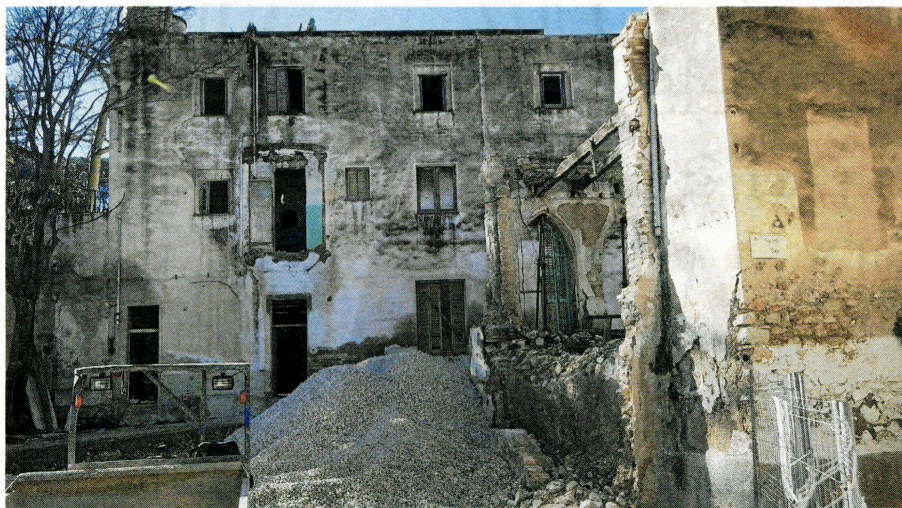
Espai de la zona del balneari del Porcar on van començar les obres. FOTO: JOAN REVILLAS
