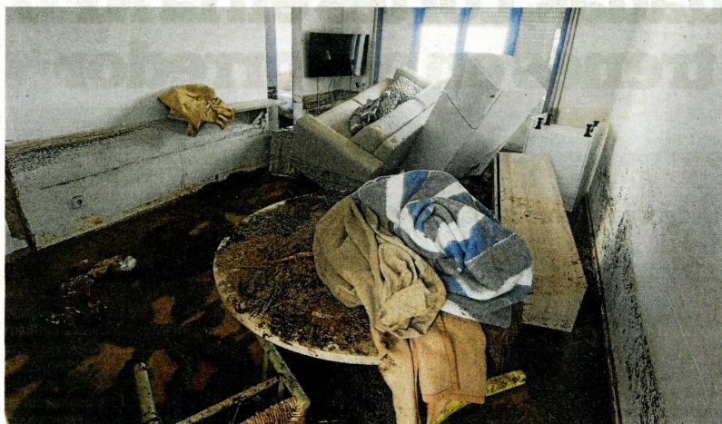
Desperfectos tras la inundación en el Camping Alfacs, en Alcanar (Montsià). FOTO: JOAN REVILLAS
