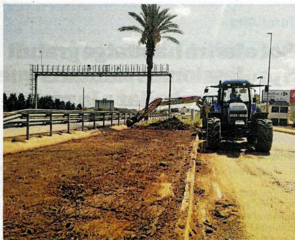
Traballs de neteja a tocar de la carretera N-340, a Amposta.
