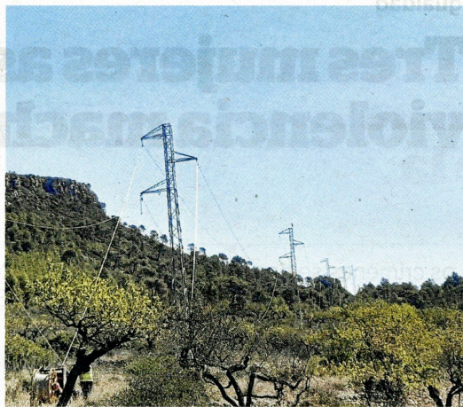
Canvi de suports de fusta per torres metàl·liques. FOTO: ENDESA
