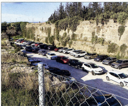
Imatge del fossar on vol construir-se el pàrquing provisional de l'HTVC. / L'EBRE
