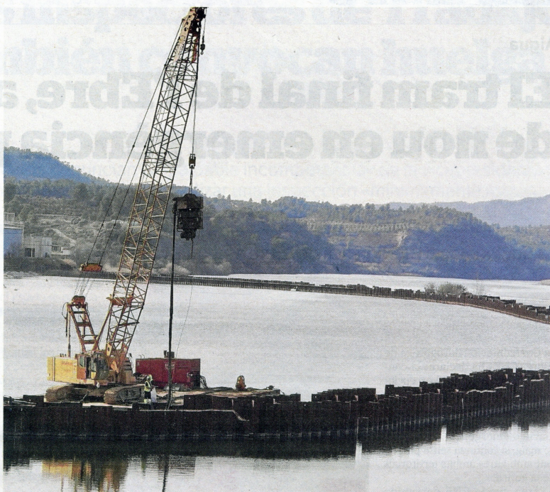
Obres de descontaminació a l'embassament de Flix, a la Ribera d'Ebre.
