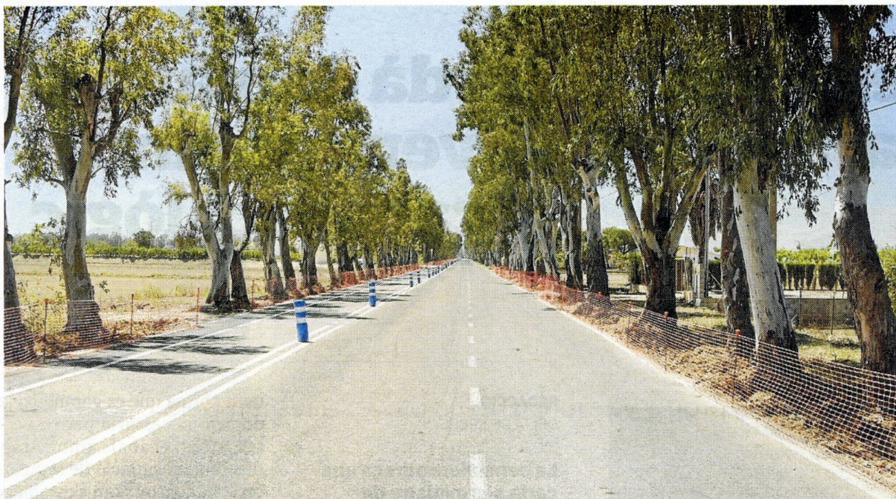
La carretera d'accés al nucli de Riumar. FOTO: AJUNTAMENT DE DELTEBRE
