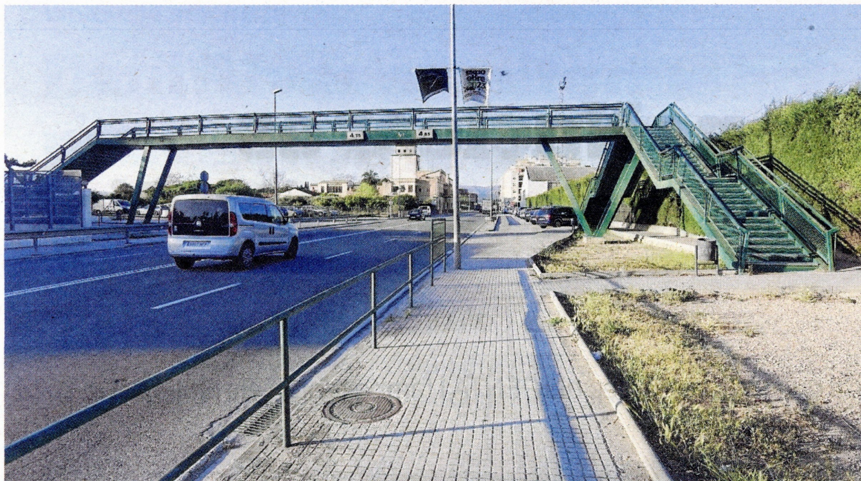
Estat actual de la passarel·la de la C-12, a l'altura de l'escola de Ferreries. FOTO: JOAN REVILLAS
