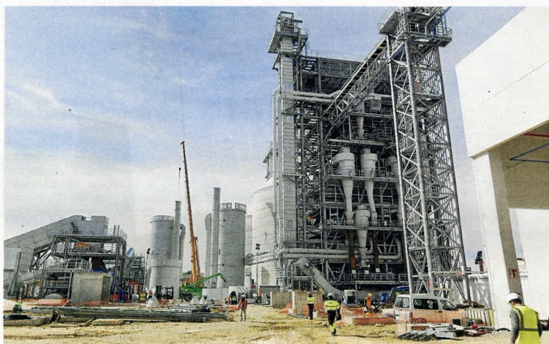
Obres a l'exterior de l'empresa Kronospan, fa unes setmanes. FOTO: JOAN REVILLAS
