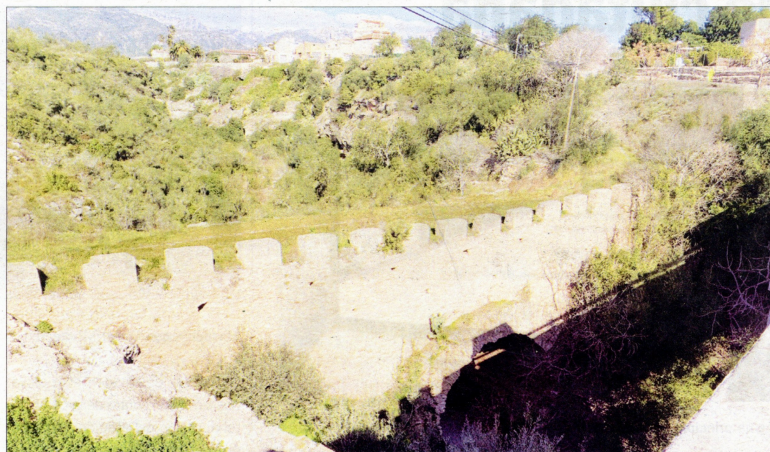
Antic pont dels Reguers que s'habilitarà com a accés per a bicis i vianants. / CEDIDA
