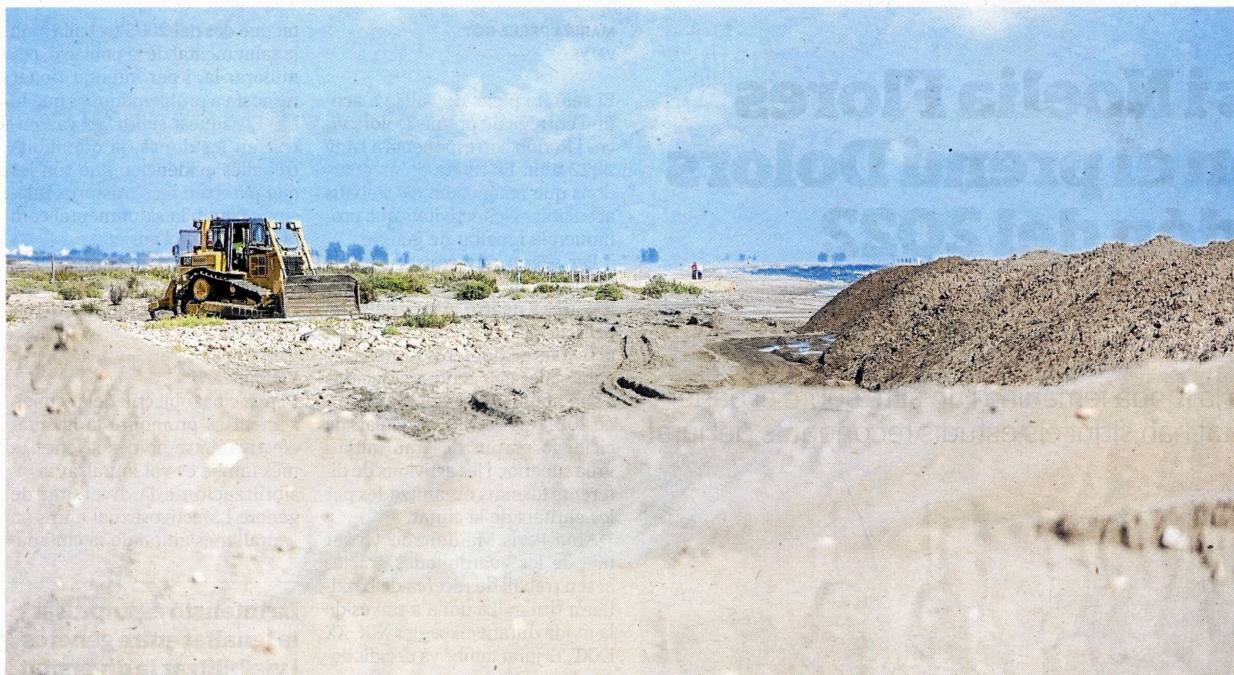
Treballs de moviment de sorres per reforçar el litoral del Delta. FOTO: JOAN REVILLAS
