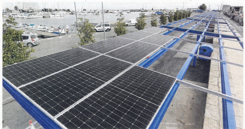
Detall dels panells fotovoltaics que s'estan instal·lant al port de la Ràpita. FOTO: J. REVILLAS
