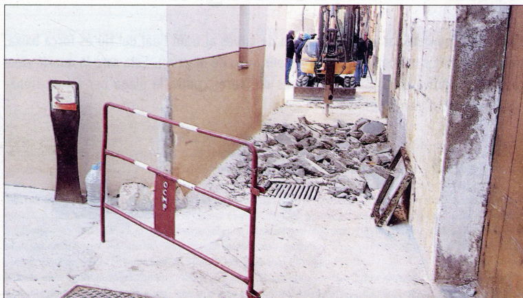
Les obres al carrer Vilanova, esta setmana.
