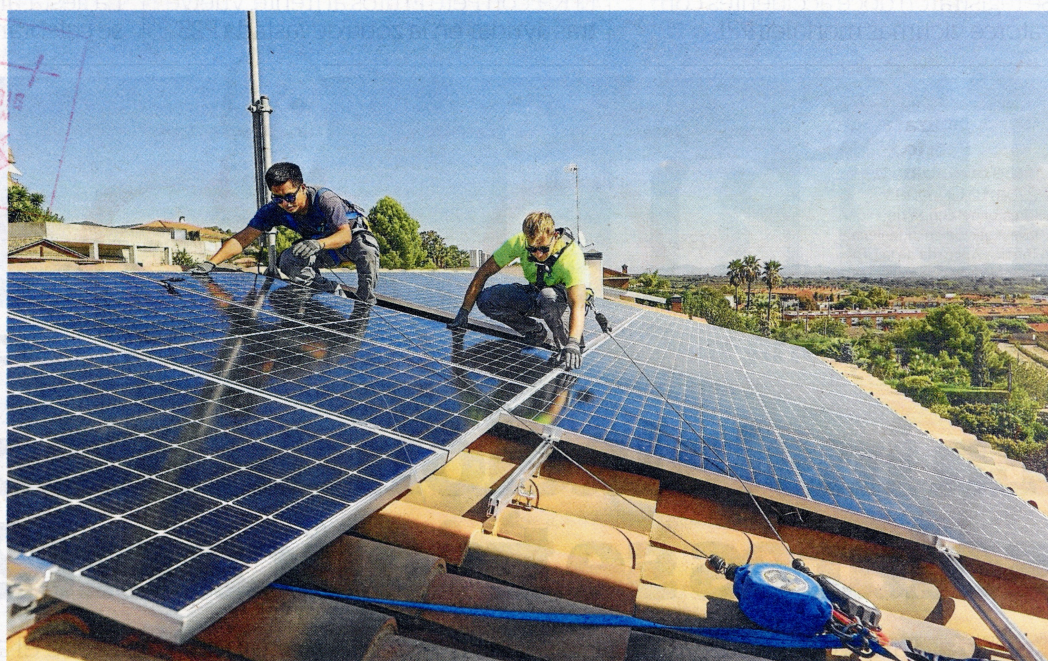
Operarios instalan placas solares en una vivienda de Castellivell del Camp. FOTO: ALBA MARINÉ
