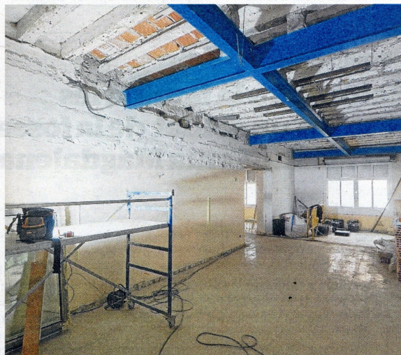
Obres en execució a les instal·lacions del tanatori de Jesús.
