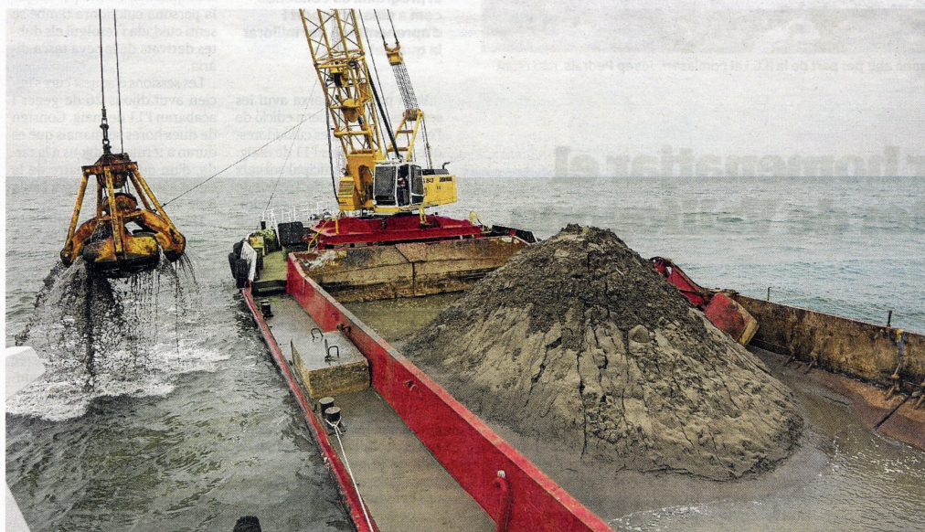
Fotografia d'arxiu del dragatge d'arenas submergides, a la desembocadura de l'Ebre. FOTO: JOAN REVILLAS
