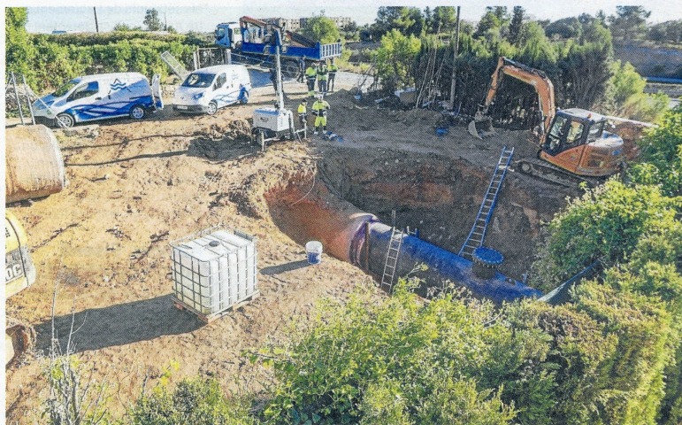
Imatge de les obres de l'anterior reparació de la canonada a l'Ametlla de Mar, el 2021. FOTO: JOAN REVILLAS
