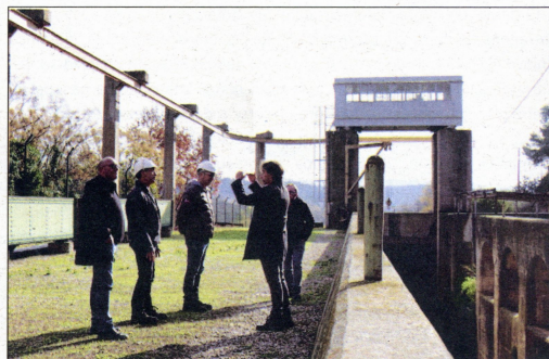
Una visita a la infraestructura durant esta setmana.
