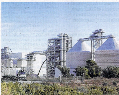
Detall de les obres en una part de la futura planta de producció.
