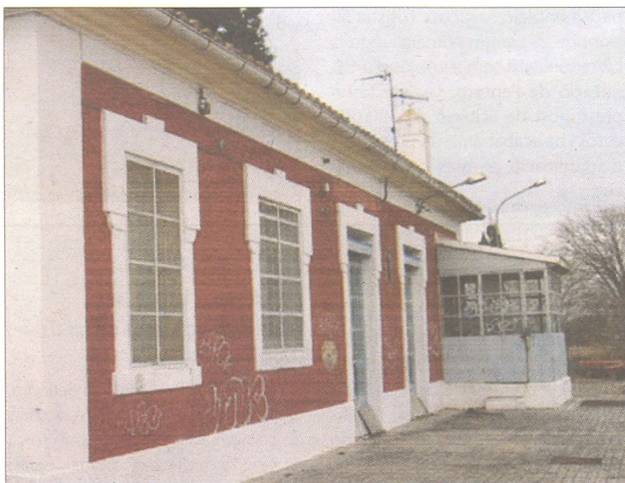
L'antiga estació de Santa Bàrbara, abandonada. / L'EBRE
