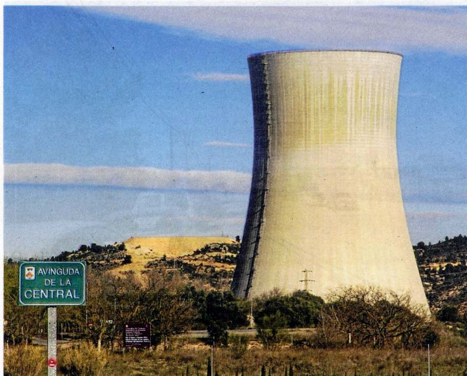
La torre de refrigeració de la central nuclear d'Ascó, a la Ribera d'Ebre. FOTO: J. REVILLAS
