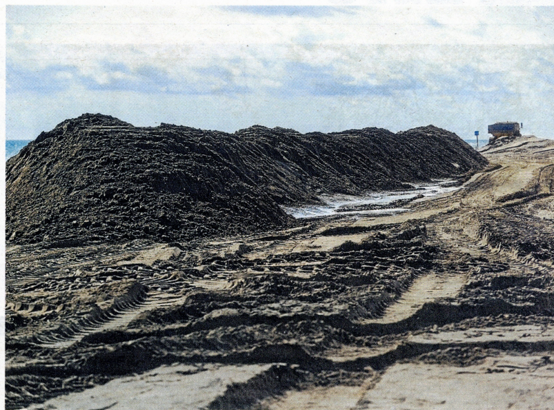
Treballs d'aportació d'arenas per protegir el litoral a la zona del Trabucador, al marge dret del delta de l'Ebre.
