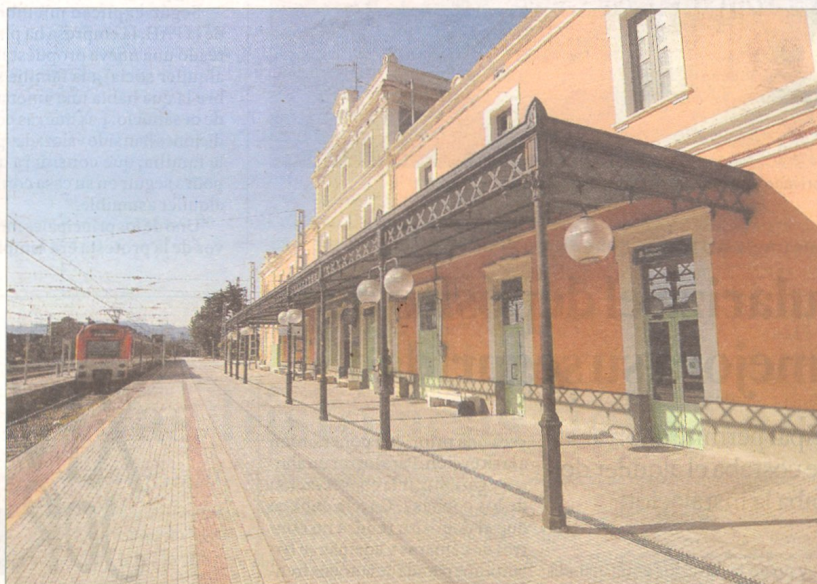
Imatge del complex ferroviari de Móra la Nova, principal estació de la Ribera d'Ebre. FOTO: JOAN REVILLAS
