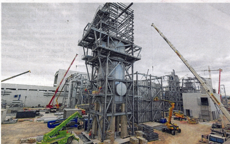
Treballs per a la construcció de Kronospan a Tortosa, la inversió més gran de la història a l'Ebre. FOTO: J. REVILLAS
