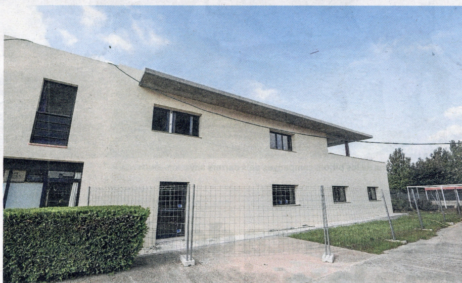
Exterior del centre residencial en obres. FOTO: JOAN REVILLAS
