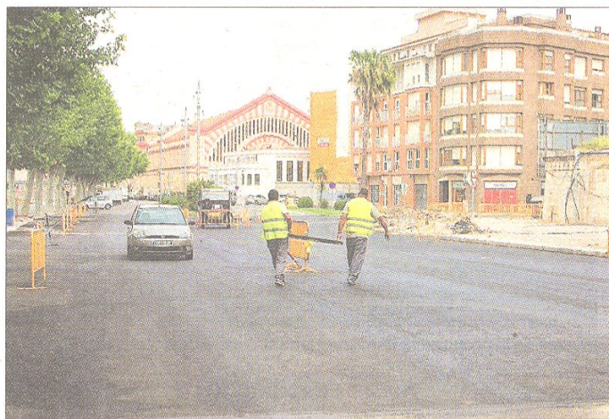
El nou asfaltat ja cobreix l'avinguda de Lleida, oberta de nou al pas de vehicles. FOTO: JOAN REVILLAS
