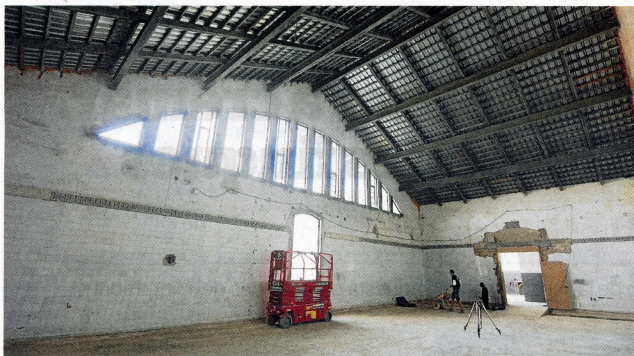
Treballs per rehabilitar el pavelló darrere de l'exposició permanent, ahir al matí. FOTO: J. REVILLAS
