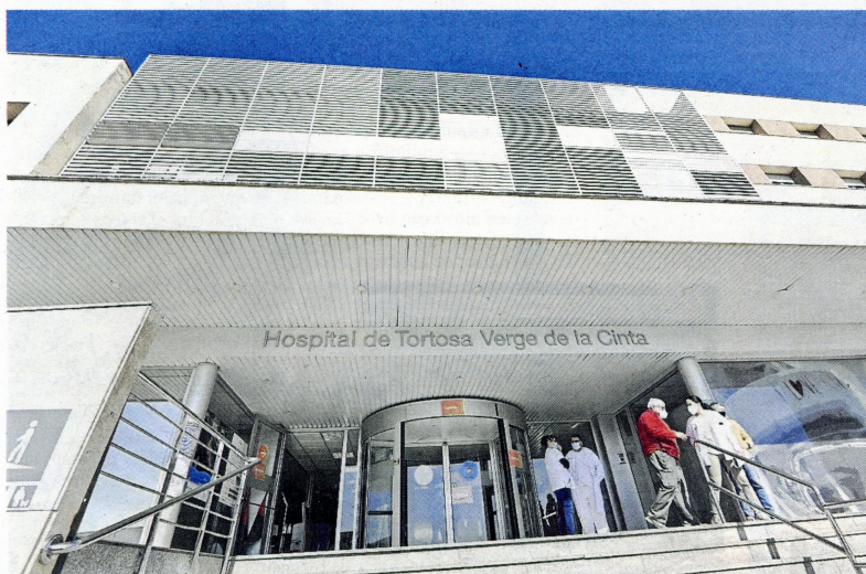
La plataforma tem que les obres al Verge de la Cinta condicionen el nou centre. FOTO: JOAN REVILLAS
