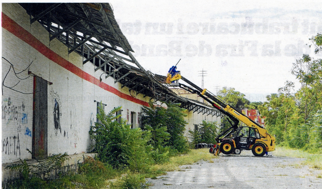
Primers treballs per part d'Adif per retirar l'amiant de la teulada dels magatzems, ahir al matí. FOTO: JOAN REVILLAS
